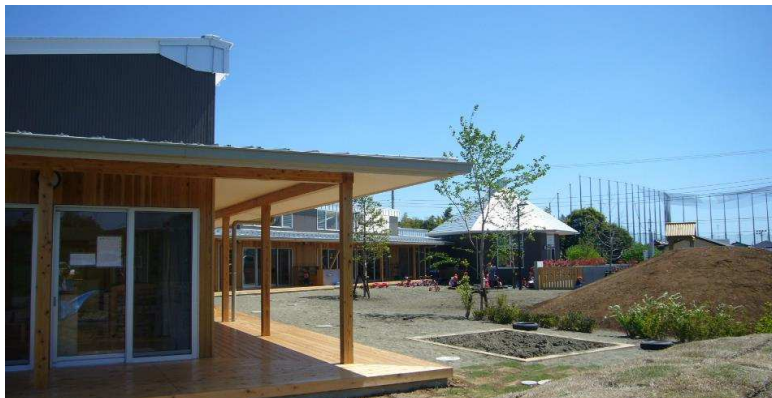
園庭から子育て支援センターを見る
